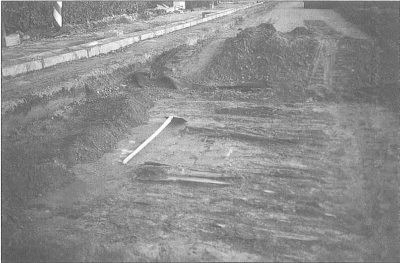
Het houten wegdek onder de Veldestraat te Merendree
